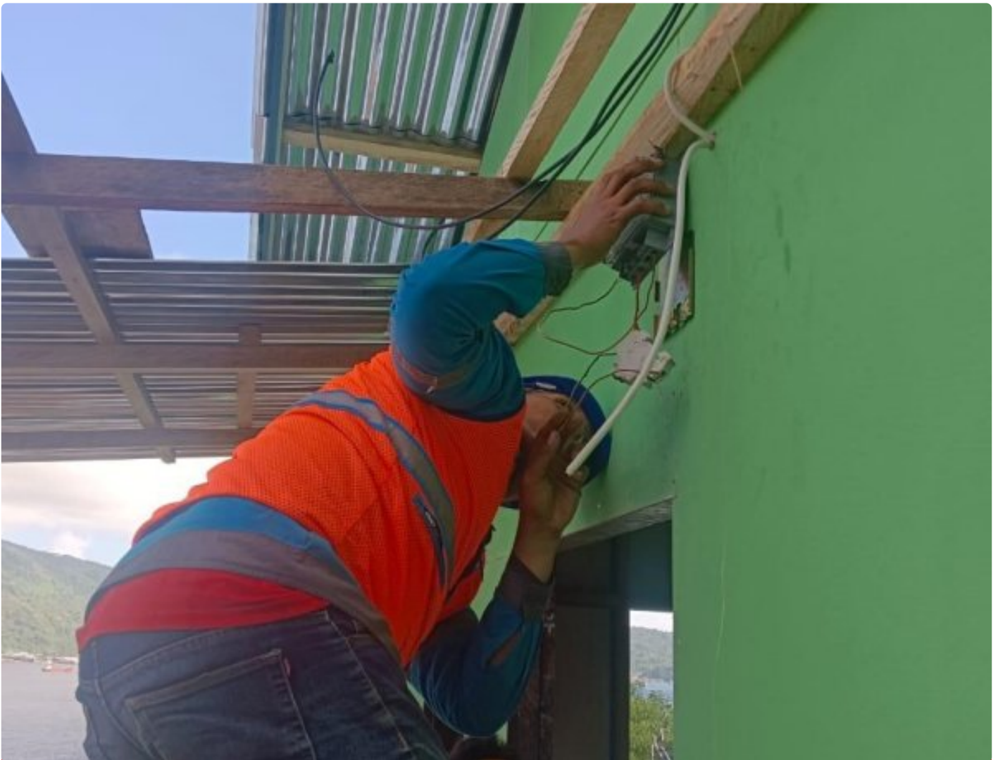
Pemasangan Instalasi RTLH oleh Satgas TMMD Ke-116 Kodim 1310 Bitung
